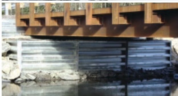
Pont et palplanches d'acier / culée GRS, Nord de l'Alberta
