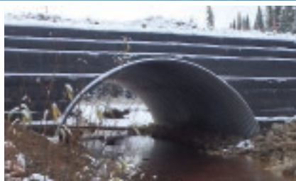
Ponts de terre renforcée par géotextile (GRS)
