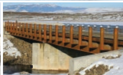
Ponts préfabriqués en acier
