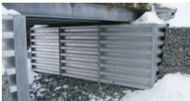
Culées Bolt-A-Bin en construction, île de Baffin, Nunavut
